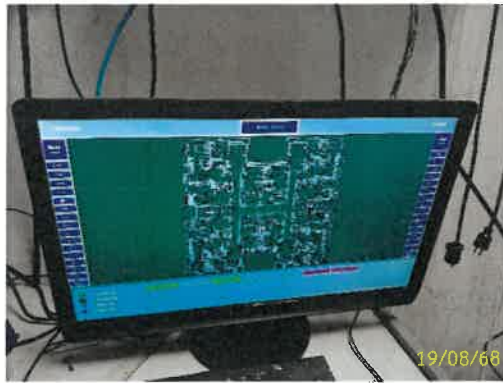
ควบคุมเปิด-ปิดไฟฟ้าในส่วนกลาง ภาพที่ 2.2-17 (ต่อ) การอนุรักษ์พลังงาน
