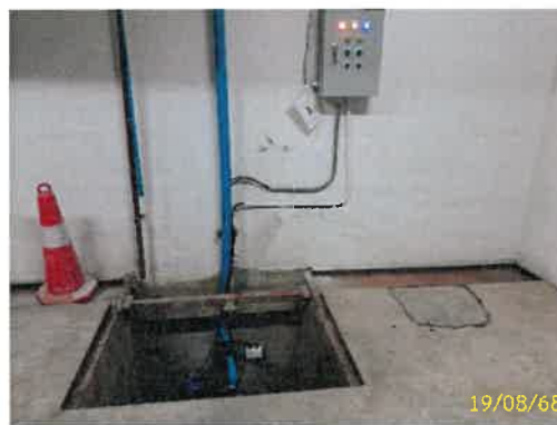
ตู้ควบคุม และบ่อบักน้ำชั้นใต้ดิน แห่งที่ 2
